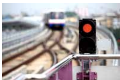
活用事例: 鉄道駅構外ネットワーク設備
