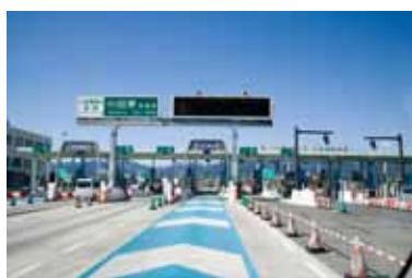
活用事例: 高速道路交通システムのネットワーク設備
