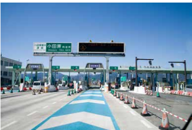
應用範例：日本高速公路系統網路設備
